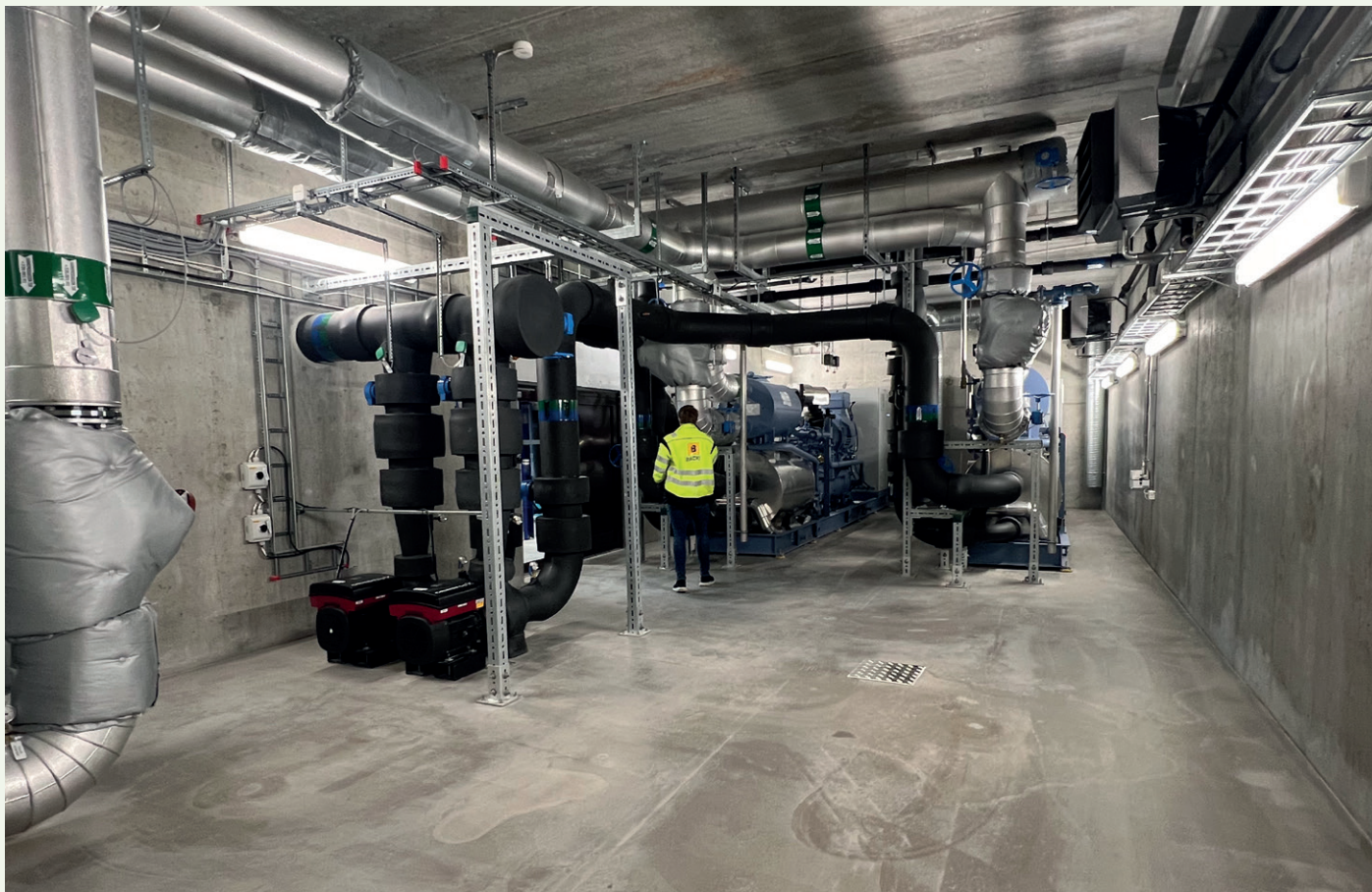
Store mengder betong er brukt i bygget. Både de prefabrickerte elementene og betongen som er brukt stedbygget er miljøklasse A. Det er også brukt noe A+ betong.
