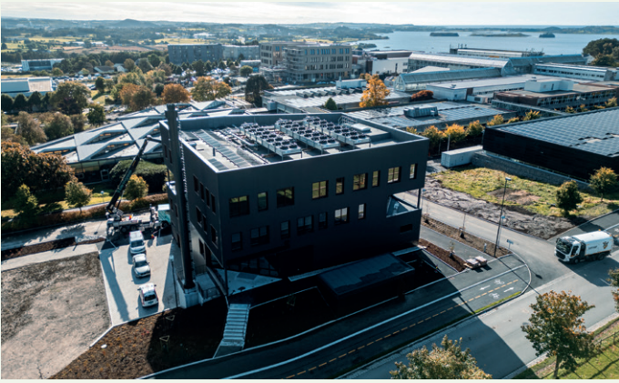
På oppdrag av Statsbygg har totalentreprenør Backe Rogaland hatt ansvar for de endelige løsningene og byggingen av energisentralen med tilbehør. Foto: Skarp/Backe
